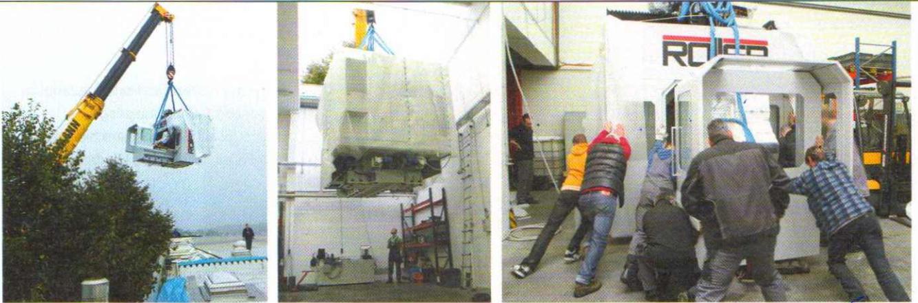
Hakenmaschine: wörtlich genommen. Drei Stunden Zeit hatten die Logistiker, um die fast 19 Tonnen schwere Maschine anzuliefern und mit einem Kran durch ein Loch im Dach in die Produktionshalle zu heben. Adrenalin pur bei allen Mitarbeitern. (Bilder: Canto)
